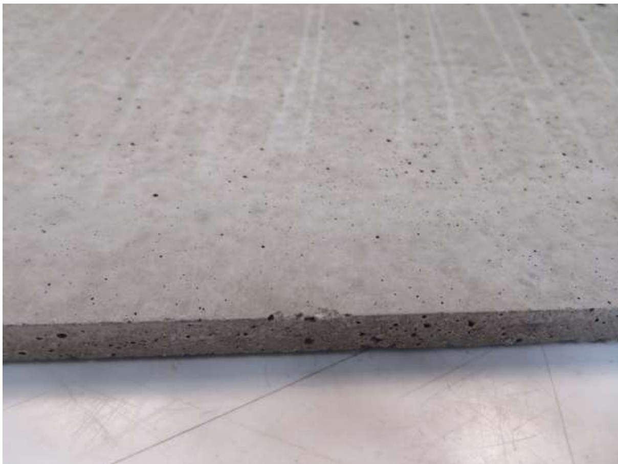
Zdjęcie. 1. Badana gładka nawierzchnia betonowa pokryta preparatem AMF ANTY-PLAMA
